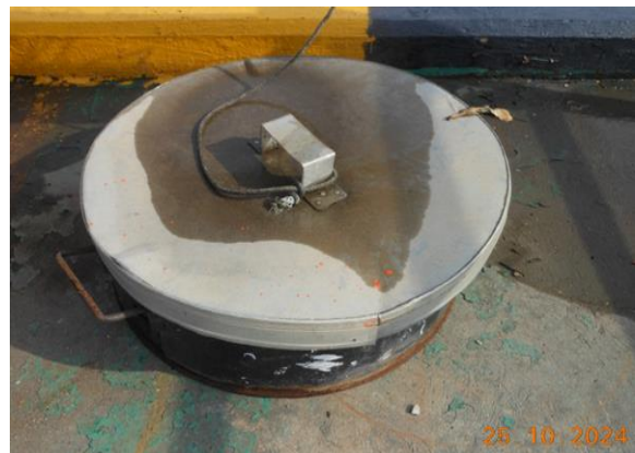
รูปที่ 2-12 ภาชนะรองรับน้ำมัน สำหรับรองรับบริเวณท่อรับ-จ่ายน้ำมัน
