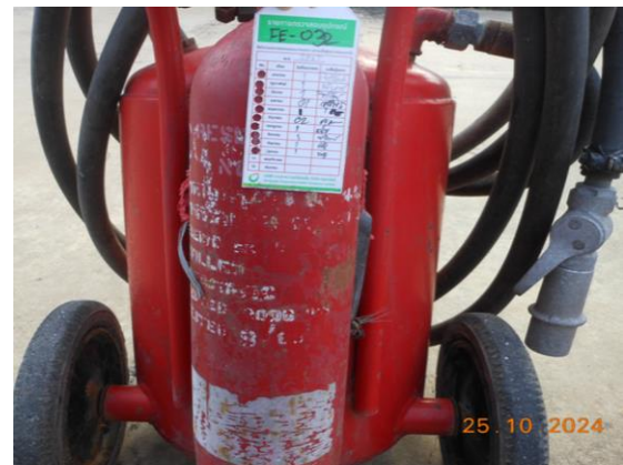
รูปที่ 2-28 การตรวจเช็คอุปกรณ์ดับเพลิงแบบติดตั้ง บริเวณหน้าท่าเทียบเรือ
