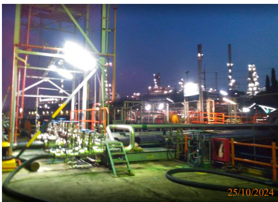
รูปที่ 2-17 ไฟสำหรับให้แสงสว่างเวลากลางคืน เพื่อความปลอดภัยขณะเรือ เข้า-ออกท่า
