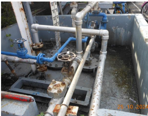
รูปที่ 2-3 Slop System สำหรับรองรับน้ำมันหกรั่วไหล
