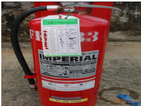
รูปที่ 2-27 การตรวจเช็คอุปกรณ์ดับเพลิงแบบมือถือ บริเวณหน้าท่าเทียบเรือ
