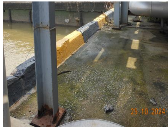
รูปที่ 2-2 คั่น Curb บริเวณขอบ Platform ของท่าเทียบเรือ
